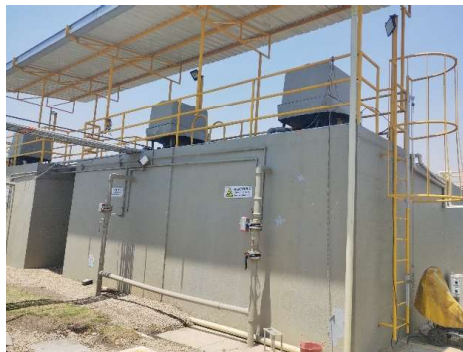
Fotografía N° 5. Reactores biológicos de aireación extendida
