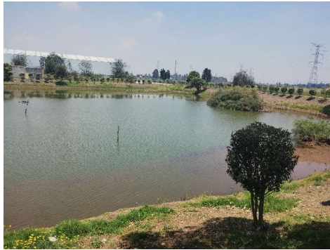
Fotografía N° 21. Pondaje N° 1 se georreferenció en las coordenadas planas Origen Único Nacional CTM 12 N: 2085074 y E: 4869411 a 2572 msnm este presenta un área aproximada de 4.427 m 2 , no presenta ningún revestimiento o impermeabilización, se observa un bajo nivel de agua.
