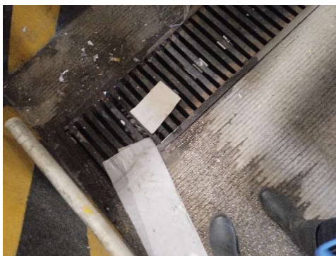
Fotografía 14. Carcamo de recolección de aguas interior de la bodega de Lacteos Apenzzell SAS que recoge las aguas generadas en actividad de lavado de canastillas de refrigerios.
