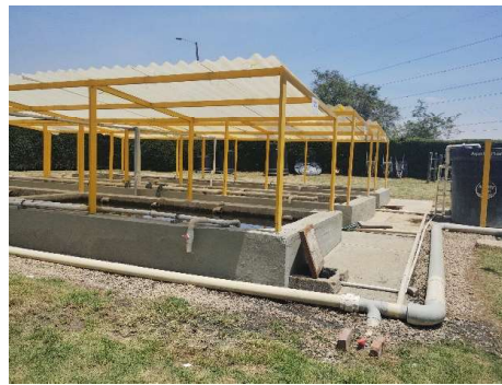
Fotografía N° 6. Lechos de secado de lodos
