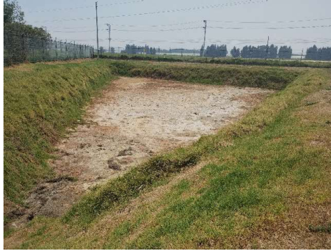
Fotografía N° 25. Pondaje N° 4 se encuentra localizado en las coordenadas Origen Unico Nacional CTM 12 N: 4868682 y E: 2083791 a 2572 msnm el cual cuenta con un área aproximada de 1.081 m 2 y una capacidad aproximada de 2.162 m 3 este pondaje es alimentado por una canal en tierra la cual se observa sin flujo de agua en el momento de la visita técnica.
