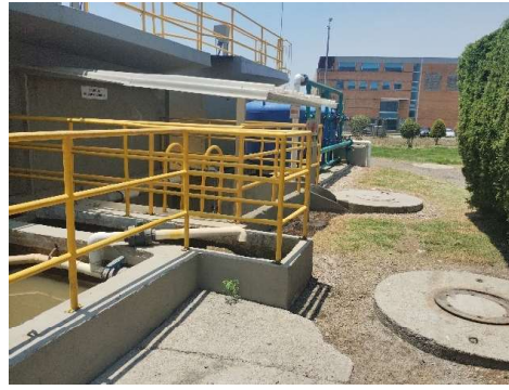
Fotografía N° 8. Tanque de decantación
