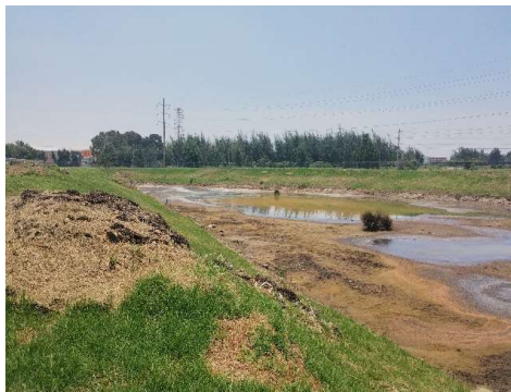
Fotografía N° 23. Pondaje N° 3 se encuentra localizado en las coordenadas Origen Único Nacional CTM 12 N: 2084007 y E: 4869606 a 2582 msnm cuenta con un área aproximada de 9.405 m 2 y una capacidad aproximada de 18.810 m 3 este presenta un nivel mínimo de agua en el lecho, asociado a las escasas precipitaciones, no cuenta con impermeabilización ni revestimiento
