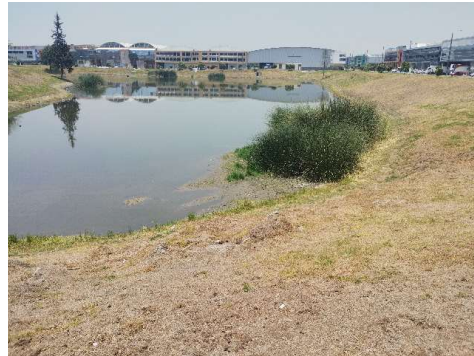
Fotografía N° 22. pondaje N° 2 se encuentra localizado en las coordenadas Origen Único Nacional CTM 12 N: 2084565 y E: 4869121 a 2572 msnm y cuenta con un área aproximada de 12.752 m 2 y una capacidad aproximada de 25.504 m 3 no se encuentra impermeabilizado ni presenta ningún tipo de revestimiento
