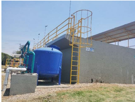
Fotografía N° 7. Tanque de decantación
