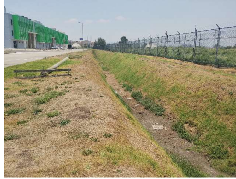
Fotografía N° 26. Canal en tierra que alimenta el pondaje N° 4 no se observa flujo de agua.
