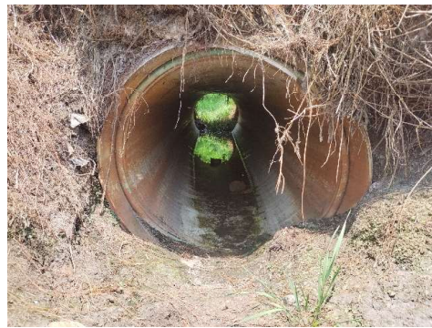
Fotografía N° 24. Tubería de ingreso de aguas lluvias al pondaje N° 3 aproximadamente 32"
